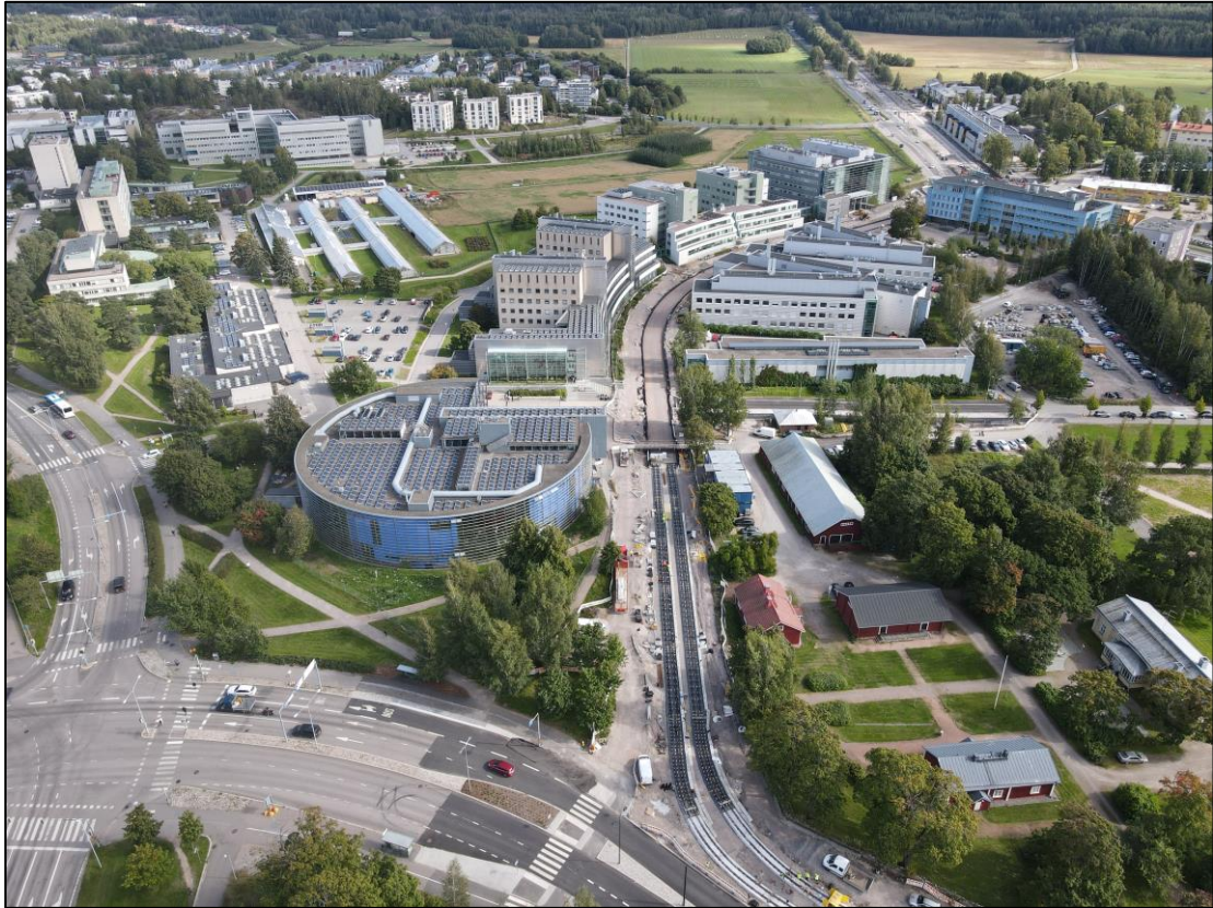
Kuva 2. Raide-Jokeri rakentumassa Viikinkaaren alueelle.
