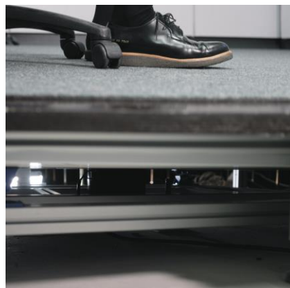
Kuva 5. Tärinälattia valmiissa huoneessa.
