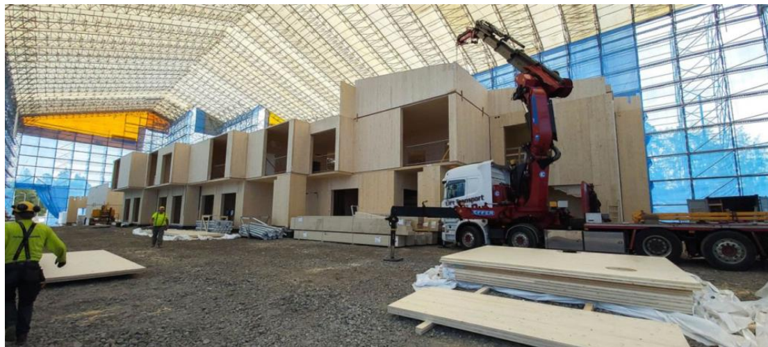
Kuva 2. Päiväkoti Hopealaakson kantavan CLT-rungon pystytys käynnissä. Kuva: Oy Rakennuspartio.
