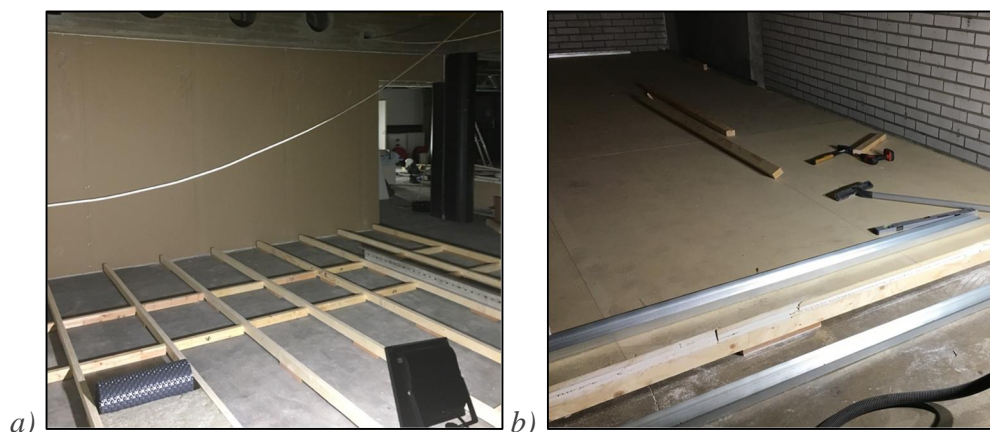
Kuva 3. Kuvia kellutetun studiolattian toteutuksesta a) ennen lattian asennusta ja b) lattian asennuksen jälkeen.
