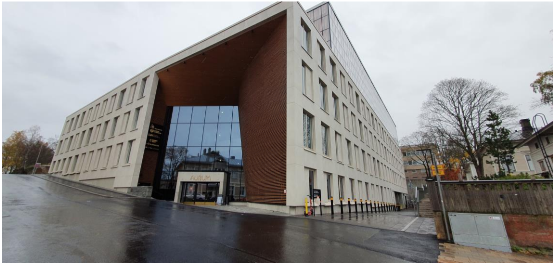
Kuva 1. Aurum-rakennus. Kuvalähde: A-Insinöörien kuva-arkisto.
