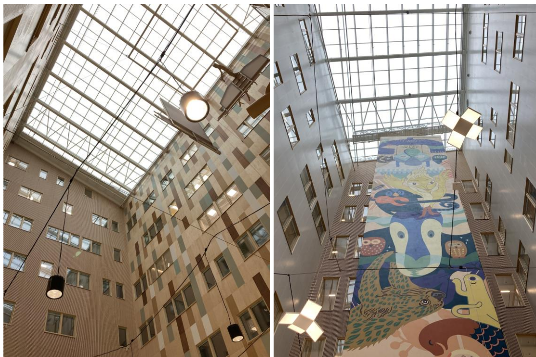
Kuva 7. Yleisnäkymät keskusauloista vasemmalla ja detailjokuva vaimennuspinnasta oikealla. Kuvälähde: A-Insinöörien kuva-arkisto.
