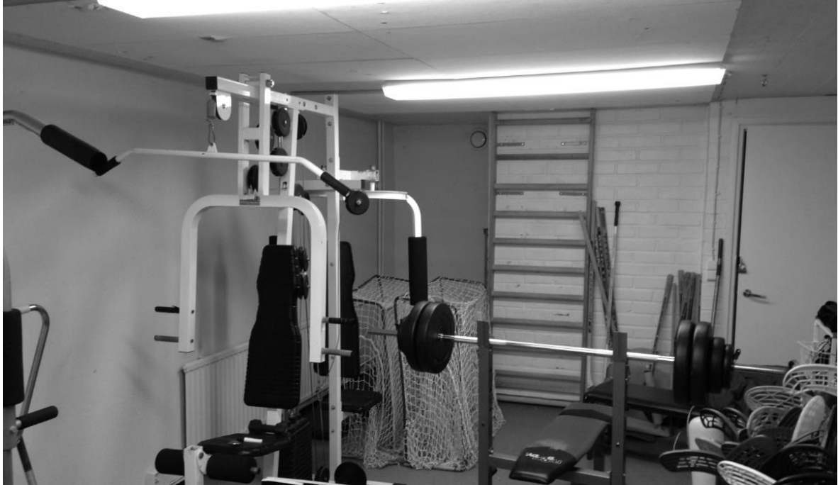
Kuva 1. Tuleva tarkkaamo oli kellarivarasto (kuntosali & liikuntavälinevarasto). Kuvassa näkyvä tiiliseinä ja betoniholvi purettiin.
