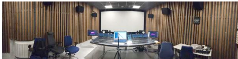
Kuva 1 Panoraamakuva Äänimaan miksaamosta. Etukaiuttimet sijaitsevat valkokankaan takana ja sivukaiuttimet on aseteltu elokuvateatterimaisesti ylös.
