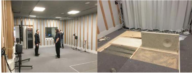
Kuva 2 Äänimaan ”kuiva” foley-stage ja kelluvan lattian sisään rakennetut askeläänilaatikat.
