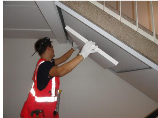
Kuva 1: Ensimmäisessä vaiheessa asennettiin vaimennusta tasanteiden kattopintoihin (vas.) ja toisessa vaiheessa myös portaiden alapuolelle (oik.).
