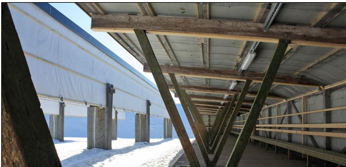
Kuva 6: Vekaranjärven ampumaradan alkuperäiset yläkulissit varustetaan absorboivalla pinnoituksella heijastusten estämiseksi. Lisäksi eräiden kulissien alareunaa madalletaan.
