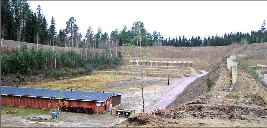
Kuva 1: Parolannummen parannettu meluntorjuntakatos sekä korotettuja meluvalleja ja keskivallia tehostava meluaita. Keskivallin molemmin puolin 150 m kivääriradat.
