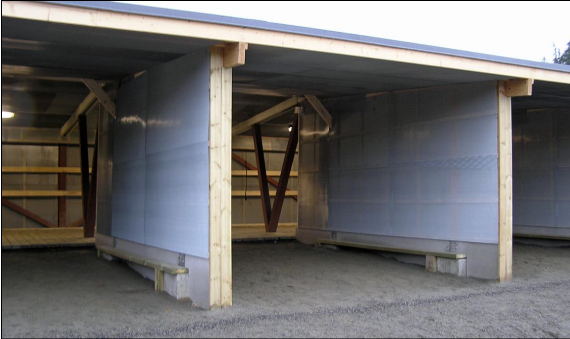
Kuva 3: Parolannummen meluntorjuntakatos. Seinäkkeet alkavat vanhan katoksen etureunasta, jossa kohdassa on myös piipun suu. Katoksen sisäpintoihin ja seinäkkeisiin asennettiin ääntä absorboivaa mineraalivillaa.
