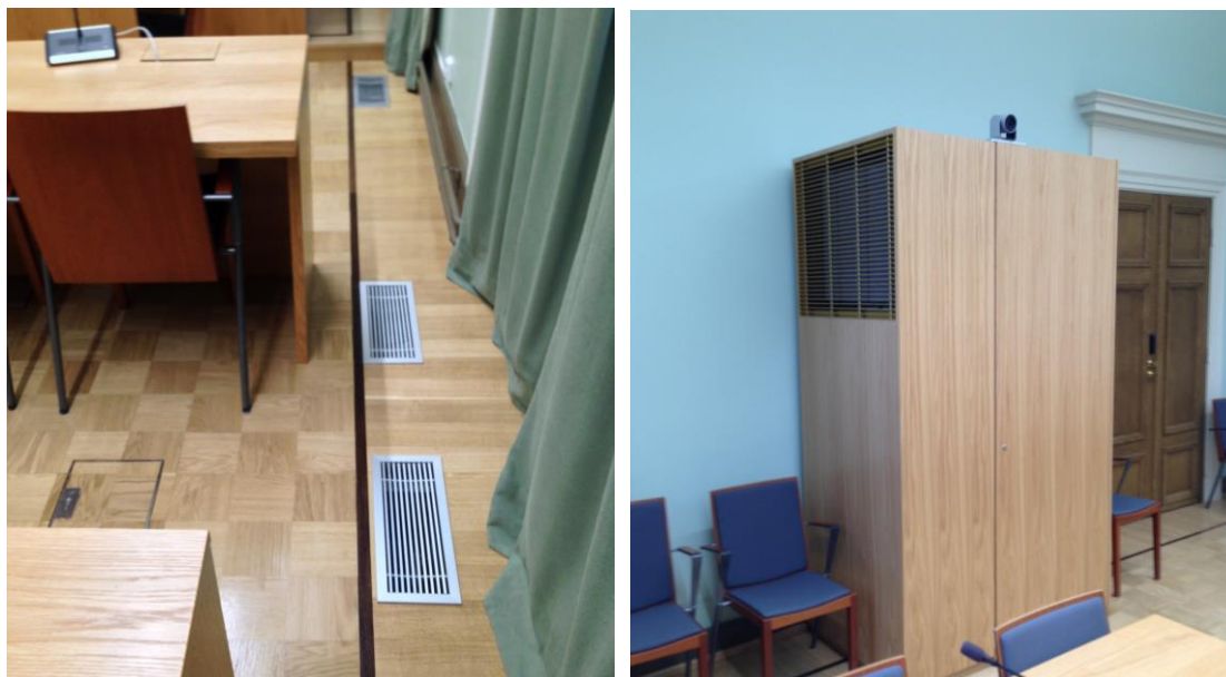
KUVA 2. Ilmanvaihdon kanavat ja päätelaitteet upotettiin rakenteisiin ja kalusteisiin.
