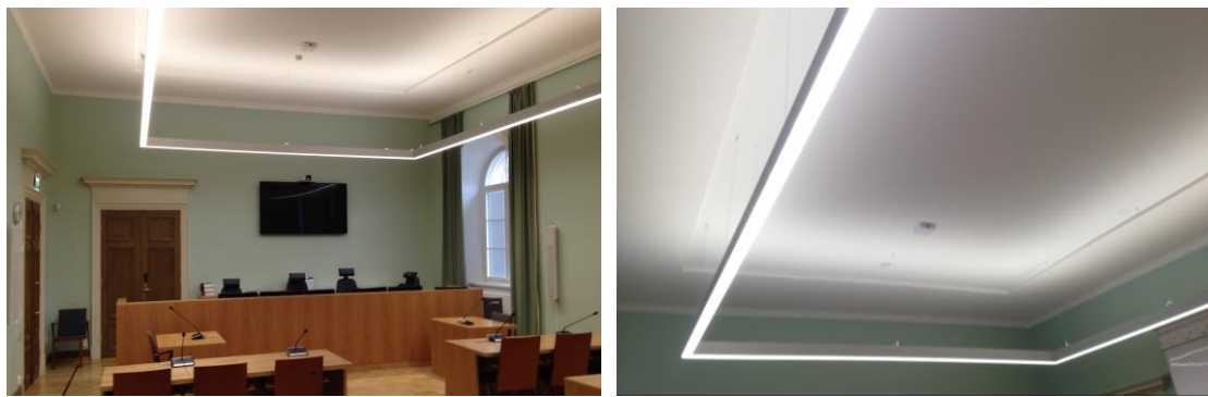
KUVA 3. Hovioikeuden istuntosali, jonka huoneakustiikkaratkaisu perustuu verhoihin sekä katon reunoilla kiertävään ruiskutettuun pintaan.
