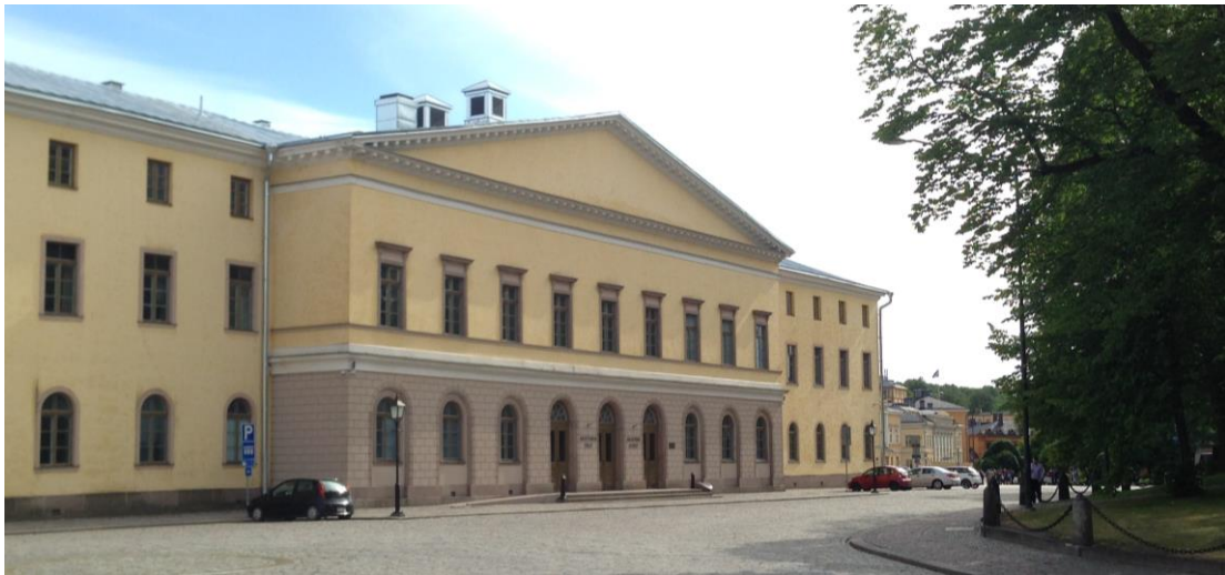
KUVA 1. Turun Akatemiatalo kesällä 2018 perusparannushankkeen valmistuttua. Katolla näkyvät uuden ilmanvaihtojärjestelmän raitis- ja jäteilma-aukot.
