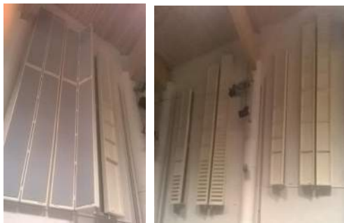
Kuva 1: Muunneltavia akustiikkaelementtejä (”Flip-Flops”) Sipoon Topelius-salissa.
